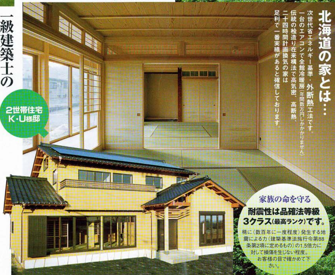
▲優雅な外観/屋根瓦の上に4.5キロの太陽光発電システム
