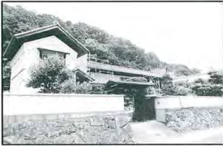
1) 200年前の家を古民家再生工事
