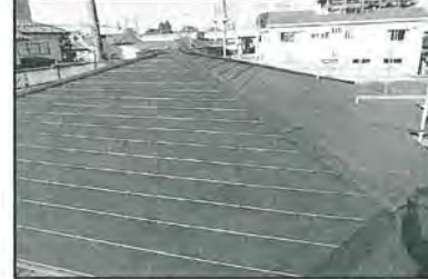
15) 古くなったスレート屋根の上に金属屋根
