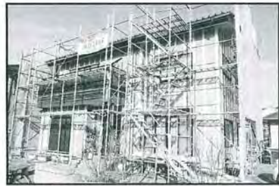
6) 20年前の外壁の上に金属外壁工事
