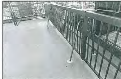
14) 既存ベランダの再防水
