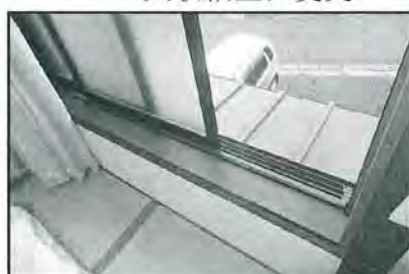
26) 結露受けの設置
