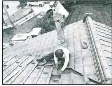
2) 瓦屋根雨もり。雪止め取付工事
