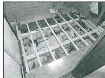
23) 床張り替えの時に調湿炭と断熱材を施工
