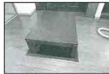
19) 洋室に堀こたつ新設
