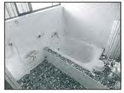
8) タイル浴室を解体してユニットバスに
