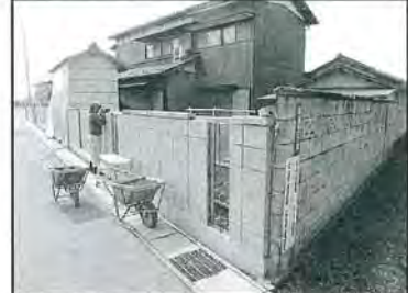
10) ブロック塀工事
