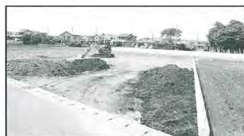
27) 測量後、他を埋立てして造成工事
