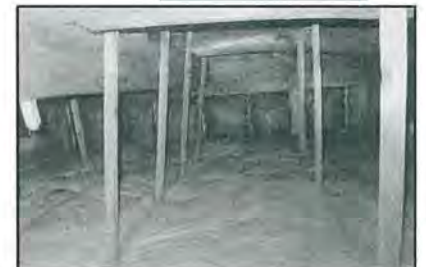
24) 天上に高性能断熱で暑さを解消。工期1日
