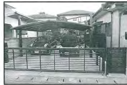
11) カーポート、アップゲート工事
