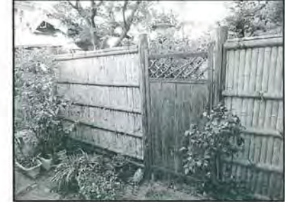
12) 竹生垣などの修理
